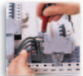
Присоединения выполняются при помощи пружинных клемм Ø 6 и 10 мм 2 .
